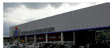
Das Würth-Hochener Baumaarktzentrum in Wörgl wurde im Sommer 2013 neu eröffnet.
