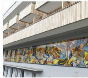
Etwa 30 Meter misst die bunte Glasfront an der Fassade des Therapiezentrum.
